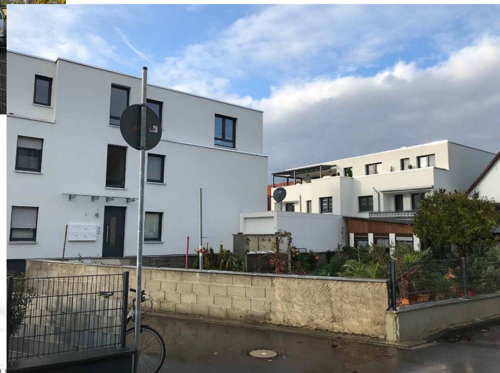
„Lachengraben Alte Mühle“ 14 Wohnungen
